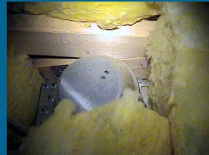
Una luz retirada que no se pudo sellar permite que aire caliente y húmedo entre a un ático sin calefacción
